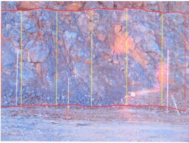
Beispiel für eine Vermessene Wand mit eingezeichneten Bohrlöchern und aufgestellten Meßlaten
