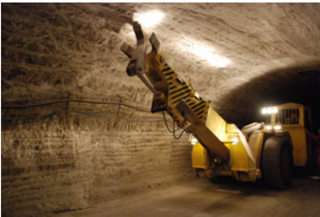
Beraubefahrzeug im Einsatz unter Tage
