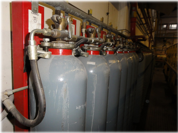
Gasflaschen (hier 45 Stück) hängen in Wiegevorrichtung.
