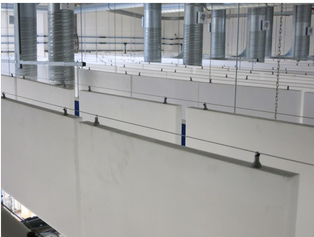
Akustikplatten - Decke
