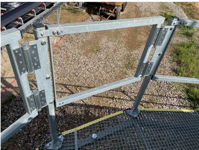
Stabile Kastenprofile mit Edelstahlscharnier
