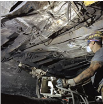
Bohrgerät im Einsatz
