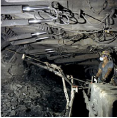
Bohrgerät im Einsatz
