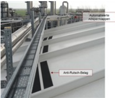
Abb. 2: Tankoberseite mit bereits installiertem Kabelkanal
