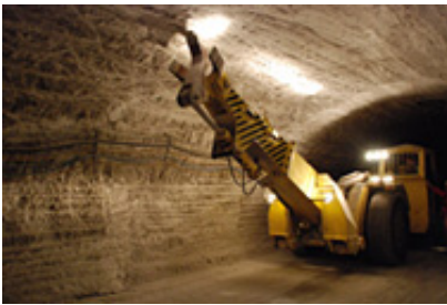
Beraubefahrzeug im Einsatz unter Tage
