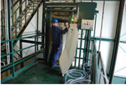
Einhängen der Wasserbehälter
