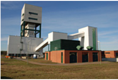
DBE Erkundungsbergwerk Gorleben
