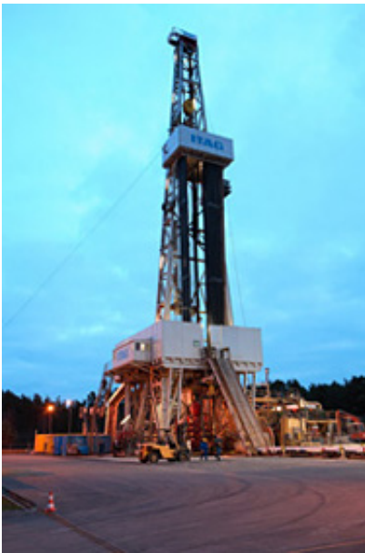
Bohrturm der ITAG Tiefbohr GmbH
