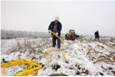
Arbeiten am Zugseil
