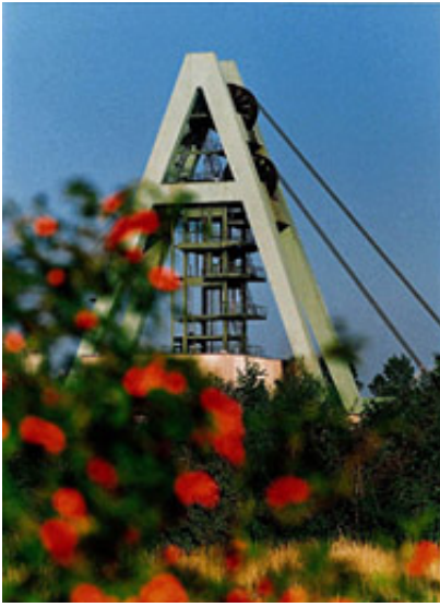
Schacht 8 des RAG-Bergwerks Auguste Victoria in Marl
