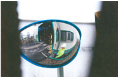
Weitwinkelspiegel im Kreuzungsbereich Fußweg und Rolltore
