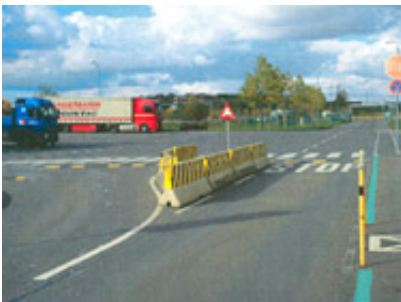
Vorgegebene Verkehrsführung durch Verkehrsinsel im Bereich Lkw-Verladung und Stopfstraße
