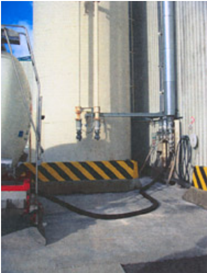
Anfahrtschutz im Bereich Additivanlieferung
