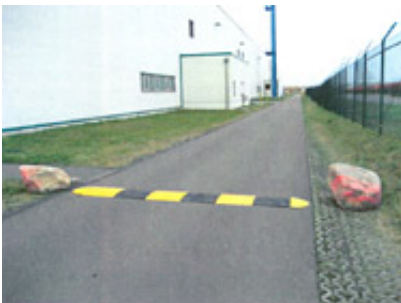
Temposchwellen auf der Umgehungsstraße im Kurvenbereich
