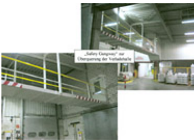
„Safety-Gangway“ zur Überquerung der Verladehalle
