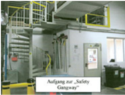
Aufgang zur „Safety-Gangway“
