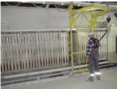
Abb. 6: Der Mitarbeiter schiebt das Gestell von Hand und befindet sich hinter der Schutzbarriere. Das Sicherheitsgeschirr dient als Absturzschutz, wenn der Mitarbeiter sich während des Entleerungsvorgangs der Presse neben das Schiebegerüst bewegen muss.
