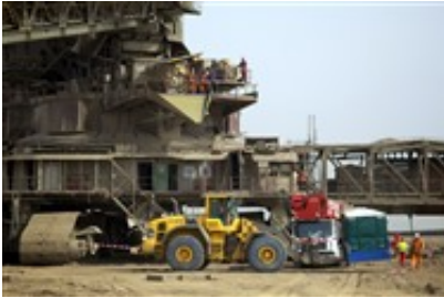
... zum Zeitpunkt von Instandsetzungsarbeiten
