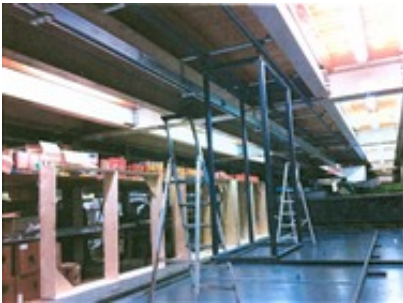
Beginn der Installation 1
