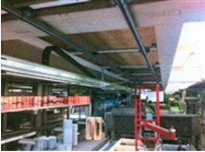
Ansicht Konstruktion unter Decke
