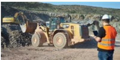
Sicherheitsmaßnahmenkontrolle auf den mobilen Baustellen.
